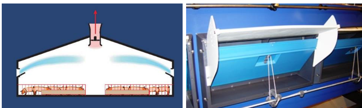
Рисунок 2.28 – Пример системы вентиляции с приточными клапанами
