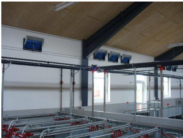
Рисунок 2.27 – Пример системы вентиляции с использованием приточных клапанов
