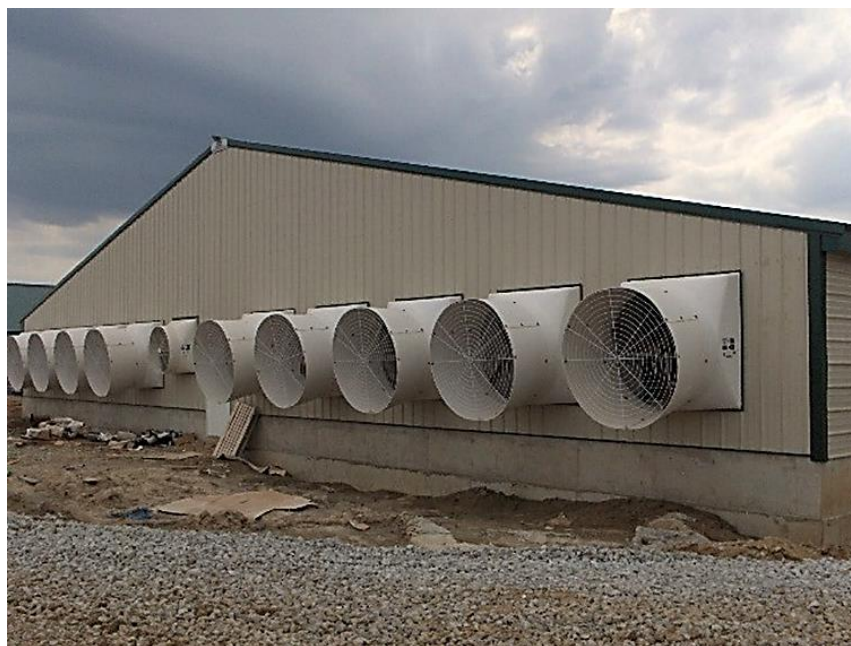
Рисунок 2.17 – Внешний вид здания с вытяжными вентиляторами
