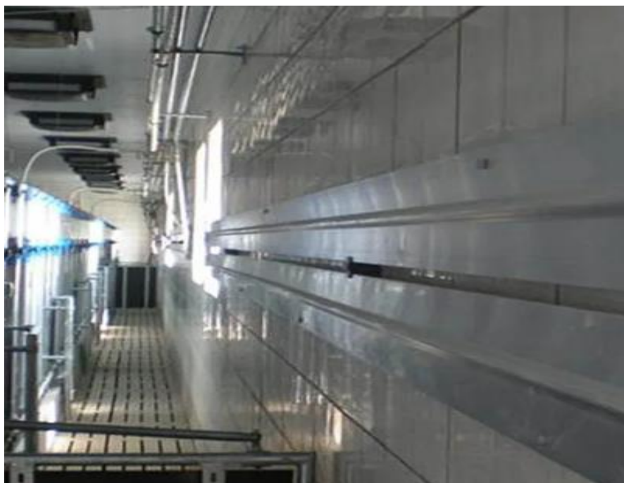
Рисунок 2.41 – Примеры установки дельта- и твин-труб
