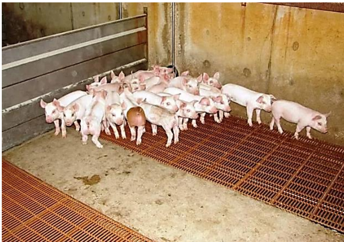
Рисунок 2.45 – Станок для содержания поросят на доразивании с участком подогреваемого бетонного пола (в центре).
