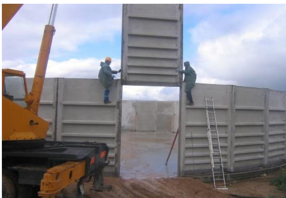
Рисунок 2.56 – Круглое сборное бетонное хранилище
