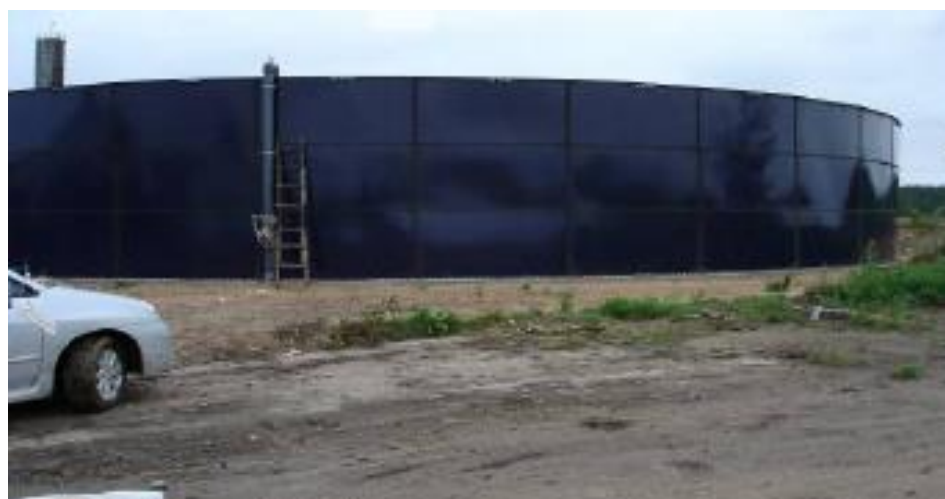
Рисунок 2.57 – Металлическое круглое хранилище (эмалированные стальные листы)
