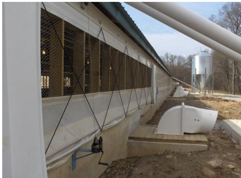
Рисунок 2.22 – Управляемая занавесь позволяет организовать естественную вентиляцию в прохладные часы суток летом
